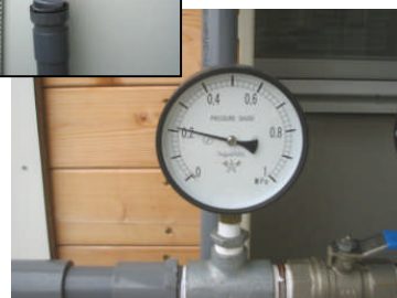
350mm製品が加圧により500mmに伸長 漏れ、異状なし
