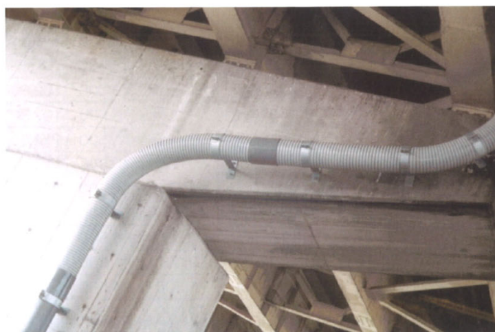
東名阪自動車道橋梁部分でのNTフレキの利用例です。
