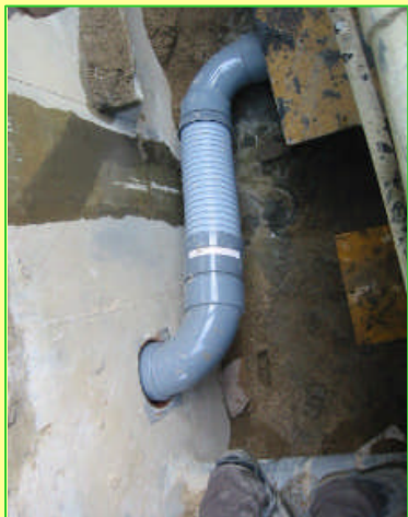
神戸市 中央区中山手通2丁目に2008年5月竣工した 大手ゼネコンのT中工務店建設物件にて 耐沈下・伸縮吸収目的で数十本使用されております。
