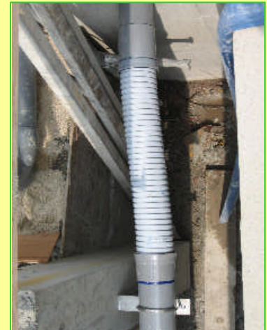
神戸市中央区中山手通2丁目に2008年5月竣工した 大手ゼネコンのT中工務店建設物件にて 耐沈下・伸縮吸収目的で数十本使用されております。
