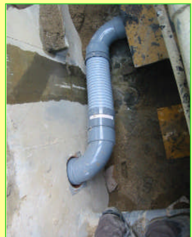
神戸市中央区中山手通2丁目に2008年5月竣工した 大手ゼネコンのT中工務店建設物件にて 耐沈下・伸縮吸収目的で数十本使用されております。
